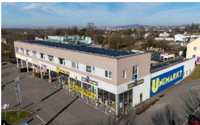
Die neue PV-Anlage produziert ca.163.000 kWh Sonnenstrom im Jahr, das entspricht dem Jahresverbrauch von 65 durchschnittlichen Haushalten.
